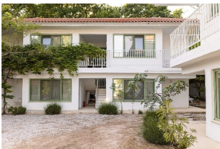
Tratare fațadă cu tencuială fină (Olimp)
