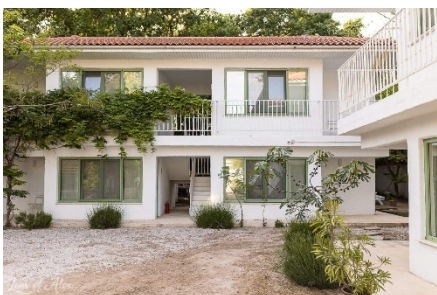
Tratare fațadă cu tencuială fină (Olimp)
