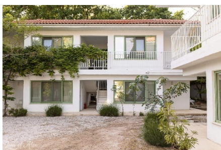
Tratare fațadă cu tencuială fină (Olimp)
