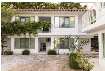
Tratare fațadă cu tencuială fină (Olimp)
