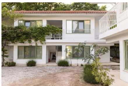
Tratare fațadă cu tencuială fină (Olimp)
